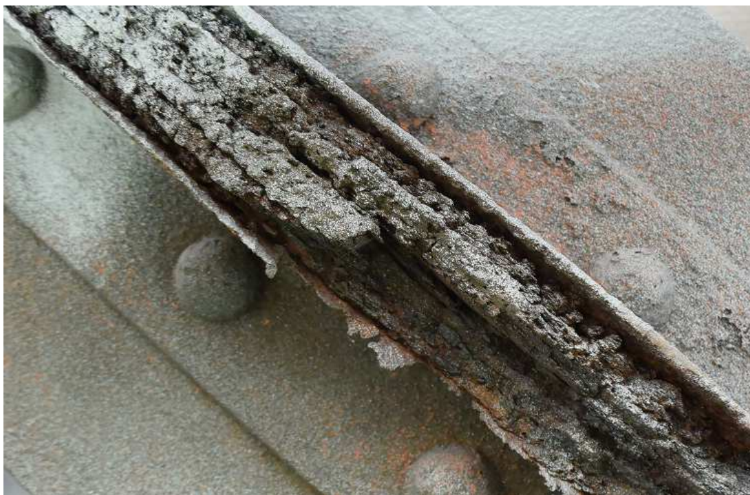
Obr. 13. Rozevírání původně nýtovaných diagonálních profilů vlivem tvorby expanzivních korozních produktů
