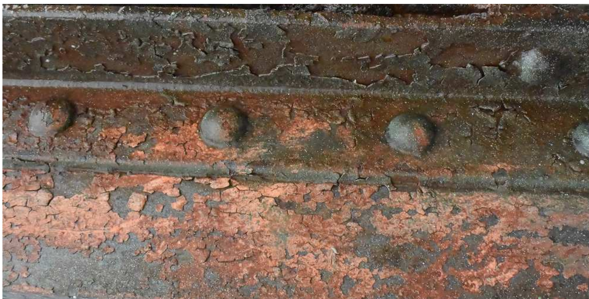
Obr. 3. Další příklad kompletního odprýskání systému protikorozních povlaků na povrchu ocelového profilu – dobře zřejmá suříková základní nátěrová hmota
