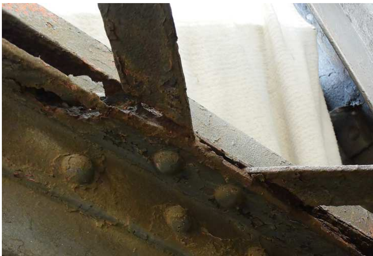
Obr. 10. Perforace v profilech diagonály vyvolaná lokalizovanou formou korozního poškození – odkorodování nýtového spoje vlivem štěrbinové koroze
