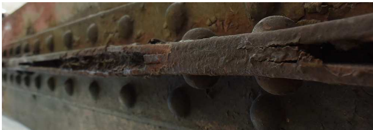
Obr. 11. Snímek dalšího z rozevíraných spojů vlivem odkorodování středního plochého vzorku s masivní tvorbou expanzivních korozních produktů
