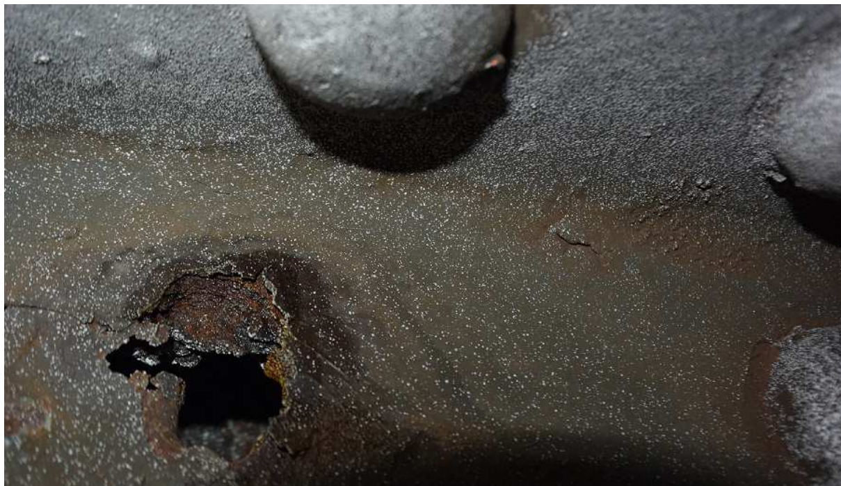
Obr. 15. Odpadnutí původního nýtu ve stojině dolního pasu vlivem štěrbinové koroze
