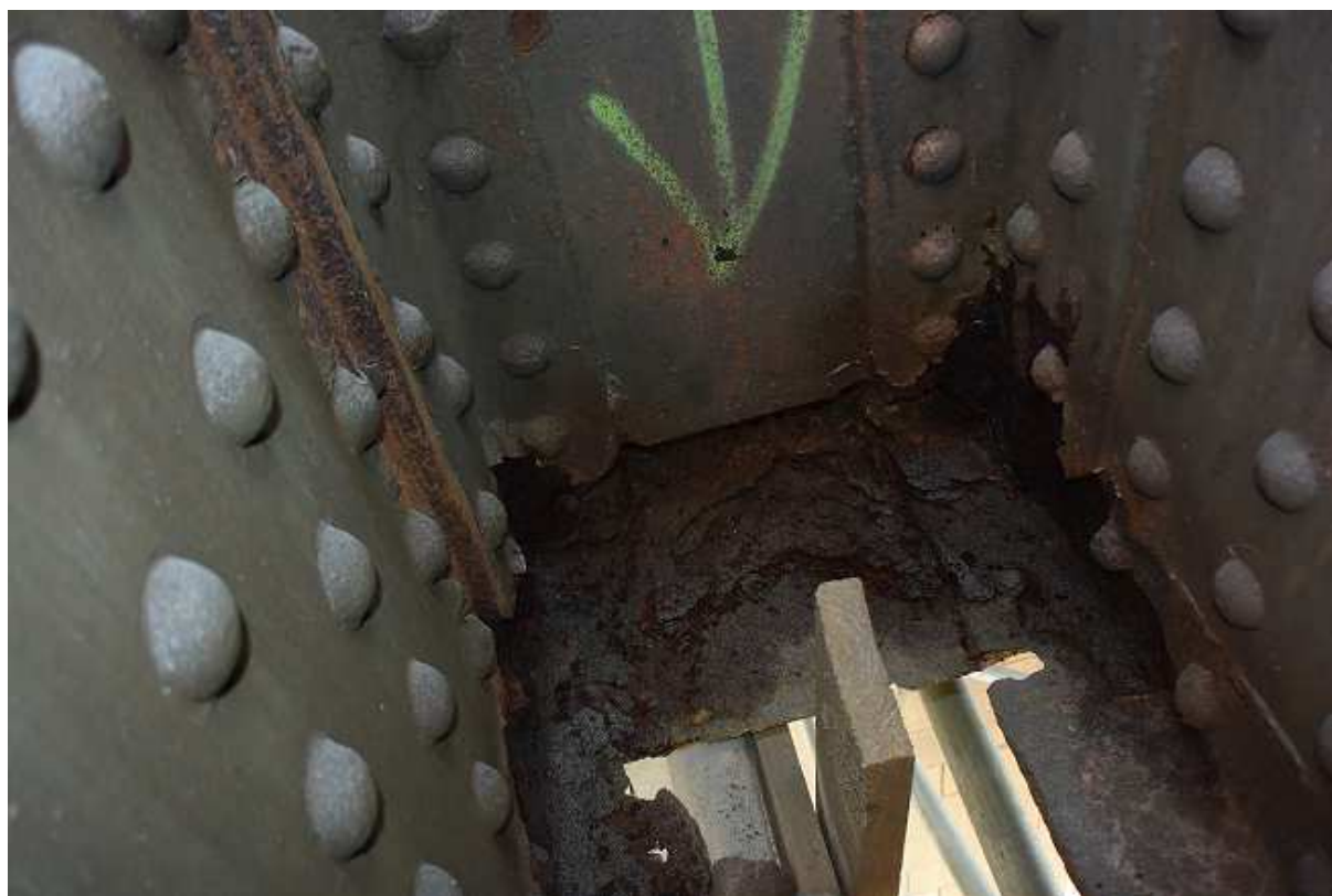
Obr. 5. Korozní úbytky a oslabení v místech napojení dolního pasu a koncové svislice vlivem koroze pod úsadami
