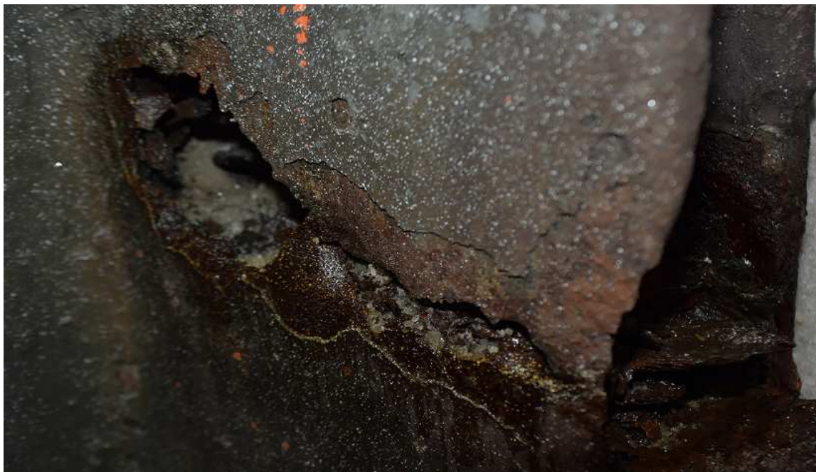
Obr. 7. Korozní úbytky v místech napojení svislic ke spodnímu pasu vlivem koroze pod úsadami (nečistoty a odprýsknuté korozní produkty)
