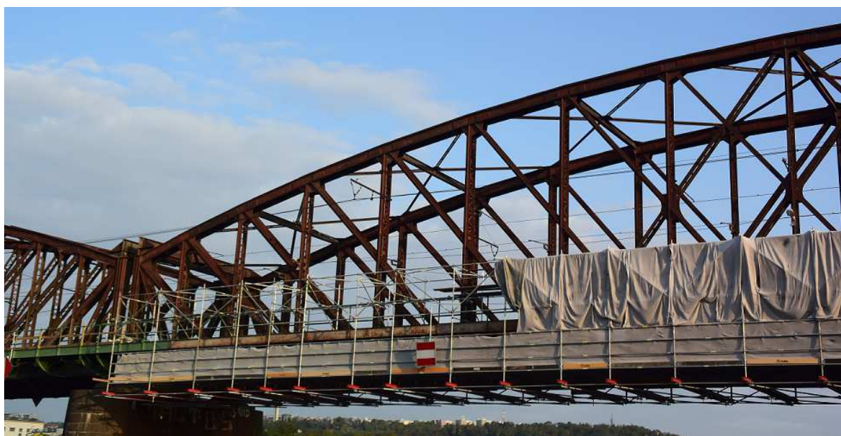
Obr. 1. Pohled na levou stranu pole NK1 ocelové konstrukce mostu pod Vyšehradem, kde byla v době odběru osazena stavební lávka umožňující přístup k běžně nedostupným částem nosné konstrukce (spodní pás)
