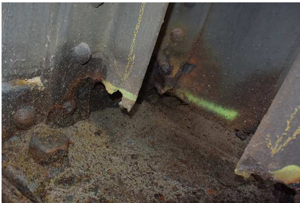
Obr. 8. Korozní úbytky ocelových profilů v místě napojení koncové svislice k dolnímu pasu vlivem koroze pod úsadami
