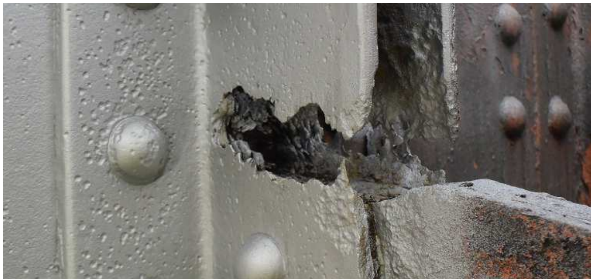
Obr. 9. Korozní úbytek přes celou šířku pásnice svislice v místě napojení ke spodnímu pasu vlivem koroze pod úsadami (nečistoty a odprýsknuté korozní produkty)
