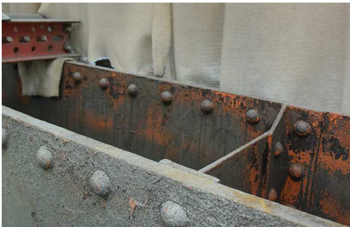
Obr. 4. Ukázka zachovalých fragmentů původního základního nátěru na suříkové bázi na vnitřních stěnách profilů
