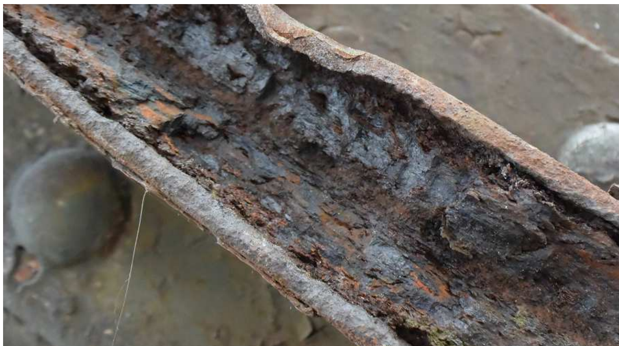
Obr. 12. Detail místa mezi nýtovanými spoji rozevřený vlivem expanzivních korozních produktů
