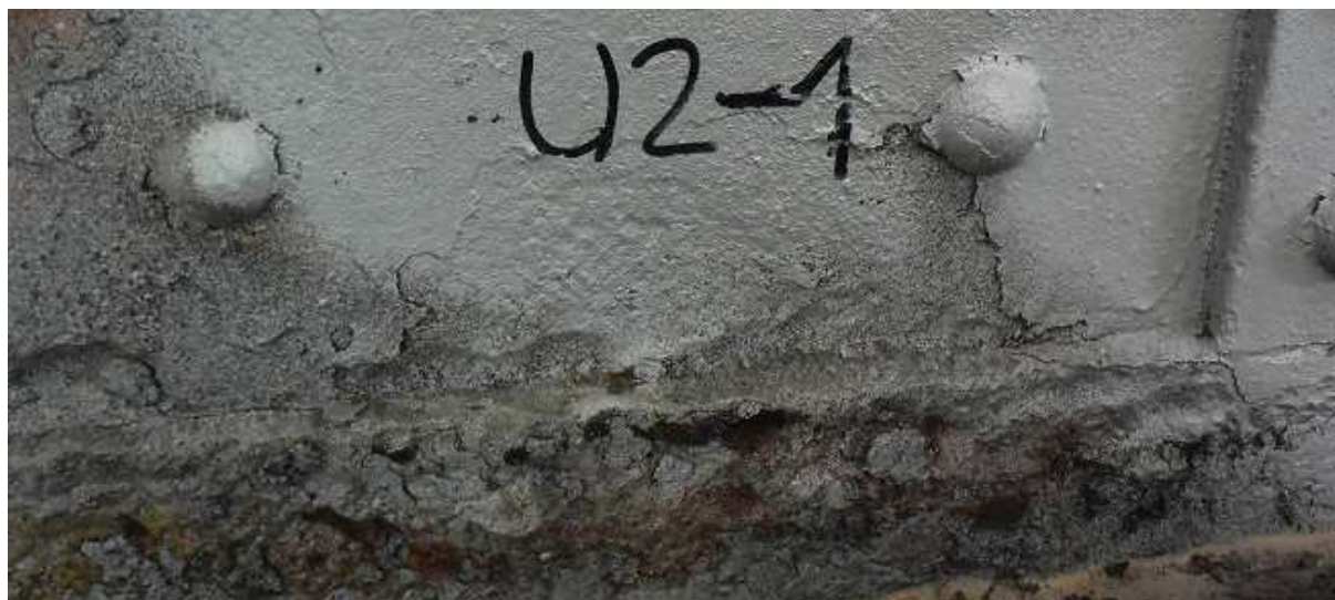
Obr. 20. Lokalizace místa odběru korozních produktů číslo 2 - NK1-L-U2
