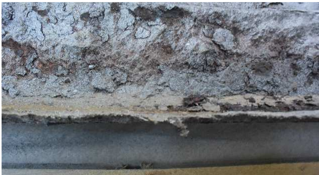
Obr. 6. Korozní oslabení krčních úhelníků dolního pasu vlivem koroze pod vrstvou úsad (korozních produktů a nečistot)
